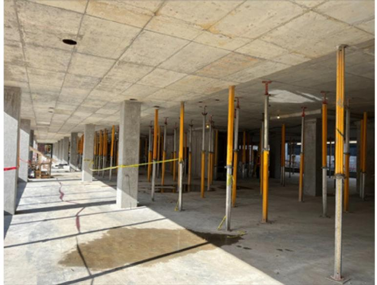
Vue du rez de chaussé. Les supports métalliques doivent rester en place jusqu'à ce que le béton soit complètement sec.
